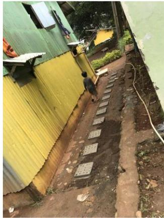
Gambar 5. Pembuatan Rabat Beton sebagai Tapak Langkah
